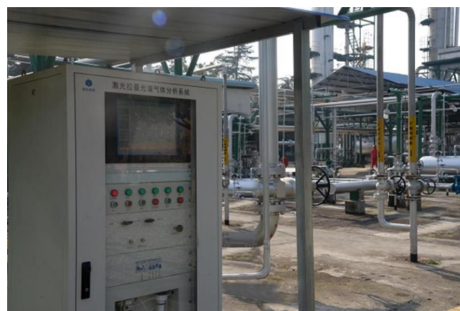
（激光拉曼光谱分析仪在天然气净化厂分析原料气）
